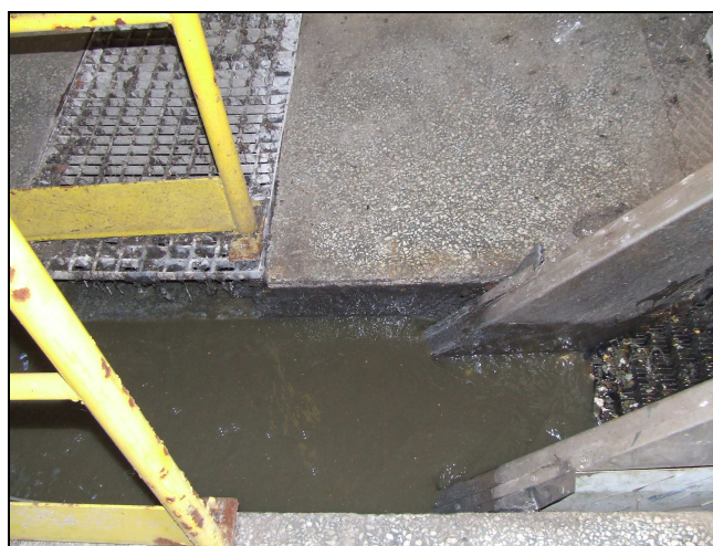
Ryc. 2 Istn. krata mechaniczna z prasą skratek
