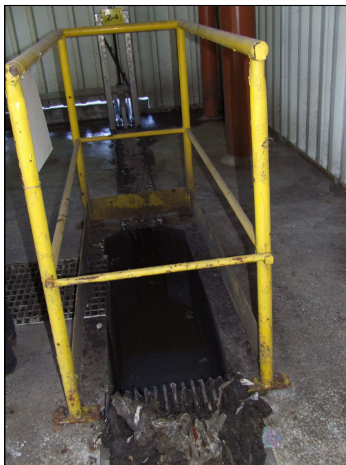
Ryc. 3 Krata ręczna na terenie oczyszczalni ścieków w Łabiszynie
