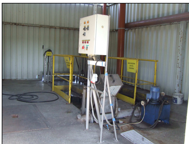
Ryc. 2 Istn. krata mechaniczna z prasą skratek
