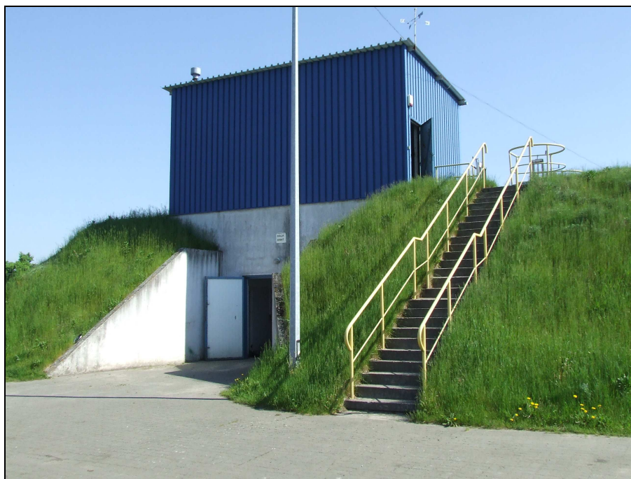
Ryc. 1 Budynek komory krat na terenie oczyszczalni ścieków w Łabiszynie
