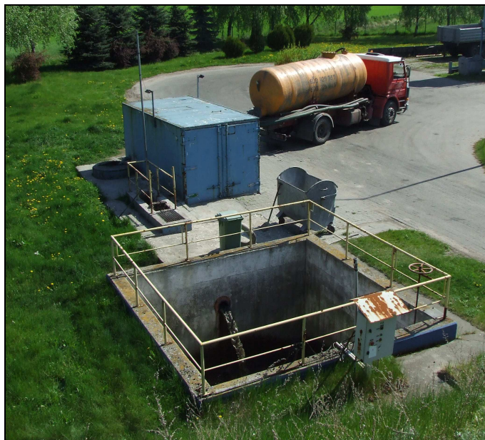
Ryc. 1 Punkt zlewny ścieków dowożonych (stan istniejący)
