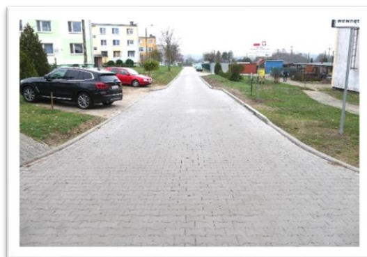
Droga w Lubostroniu
