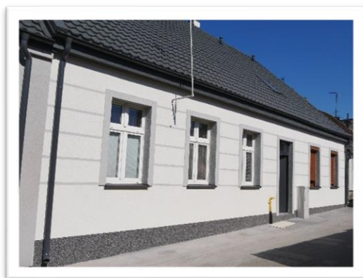
Modernizacja budynku ul. Sienkiewicza
