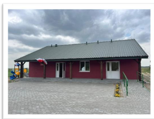
Budowa Świetlicy w Ostatkowie wraz z zagospodarowaniem terenu (kontynuacja zadania w 2026 roku)
