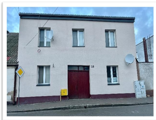
Modernizacja budynku komunalnego przy ulicy 11-stycznia 18
