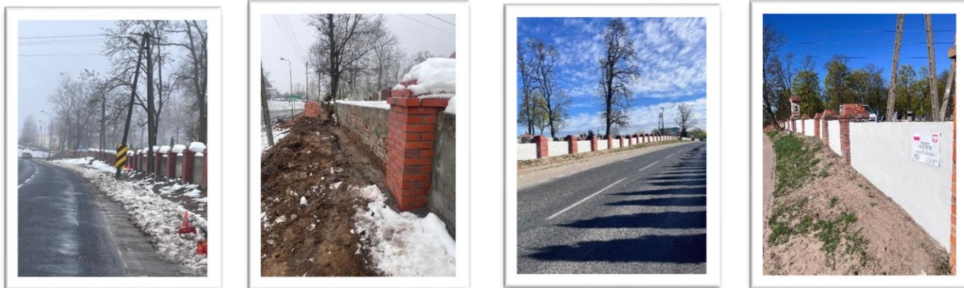
Prace remontowo-konserwatorskie ogrodzenia cmentarza parafialnego z XVIII/XIX wieku w Łabiszynie
