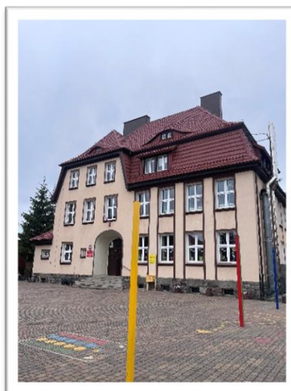
Modernizacja dachu Szkoły Podstawowej w Łabiszynie przy ul. Poznańskiej
