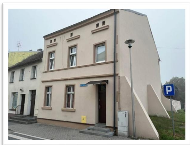
Modernizacja budynku komunalnego przy ulicy Rynkowej 3
