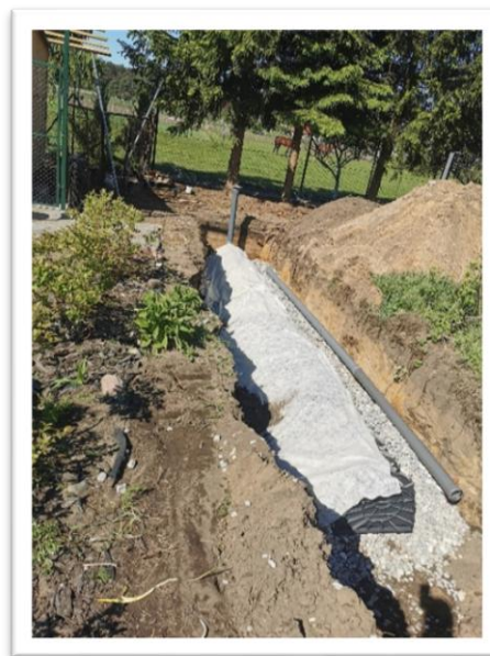
Montaż przydomowej oczyszczalni ścieków
