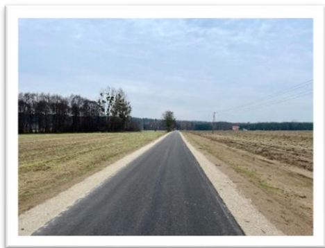
Modernizacja drogi Ostatkowo-Klotyldowo
