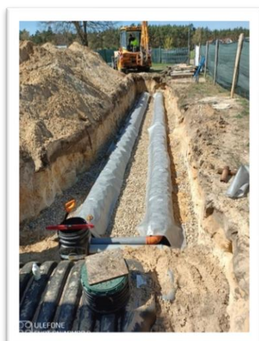
Montaż przydomowej oczyszczalni ścieków
