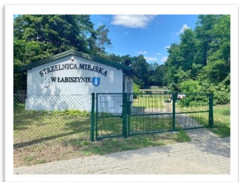
Budowa ogrodzenia Strzelnicy
